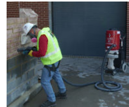
FOTO CORTESÍA DEL INSTITUTO INTERNACIONAL DE ALBAÑILERÍA
