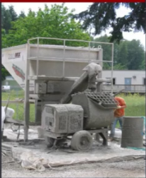
A. MORTAR MIXER
